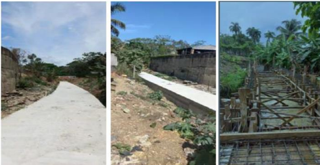
Ilustración 1: Intervenciones cañada Marañón, Santo Domingo Norte
