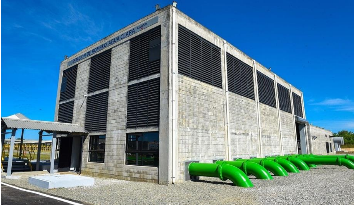
Ilustración 3: Estacion de bombeo Agua Clara, Sistema Barrera de Salinidad
