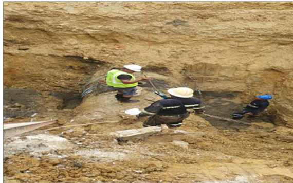
Corrección de avería en línea de 67 pulgadas LJ, calle acueducto Esq. Calle del Noroeste, Las Casitas de San Luis.
