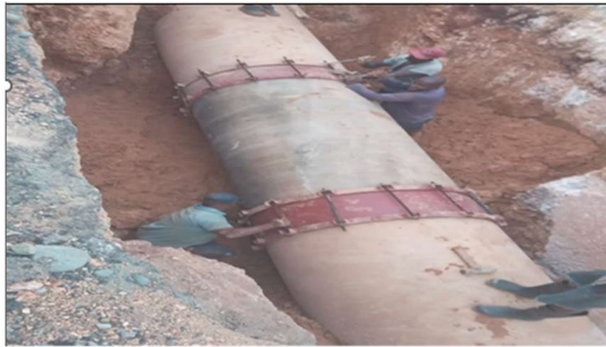
Corrección de avería en línea de 48" Ave. San Vicente de Paul, esquina Club de Leones, Santo Domingo Este.
